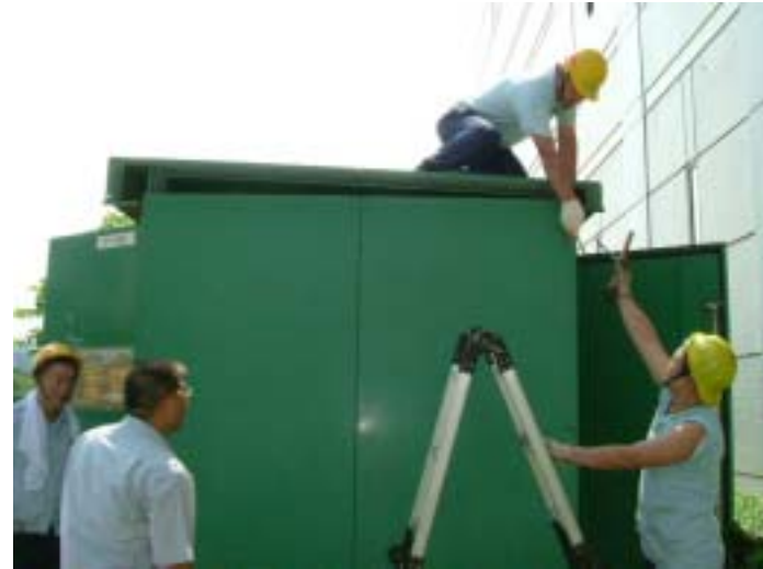
DS盤體修復施工照片二
