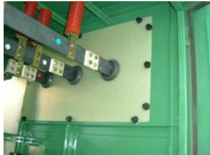
盤中所有螺絲皆使用橡膠帽套蓋住
