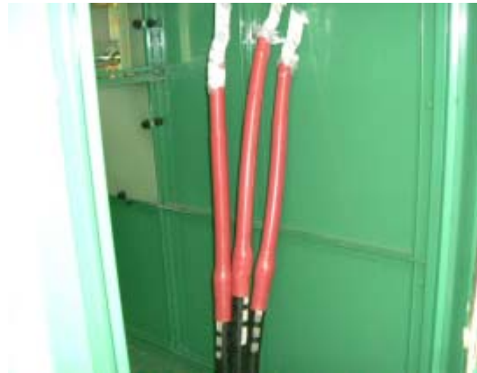
高壓電纜電纜頭處理
