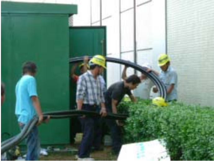
DS盤重新鋪設高壓電纜線照片
