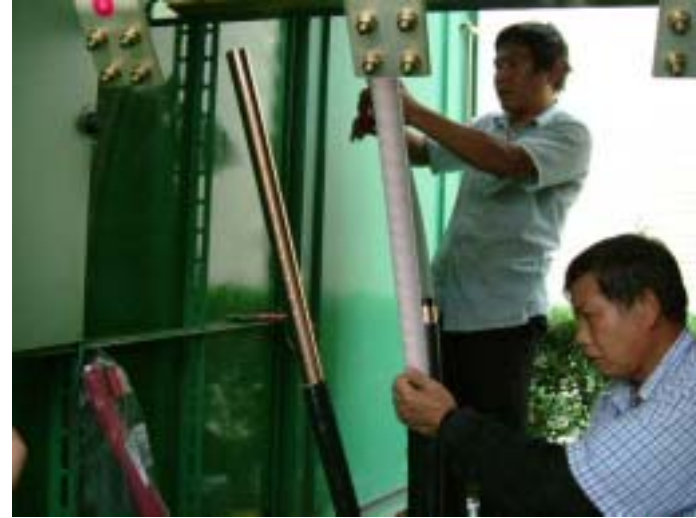
高壓電纜電纜頭處理
