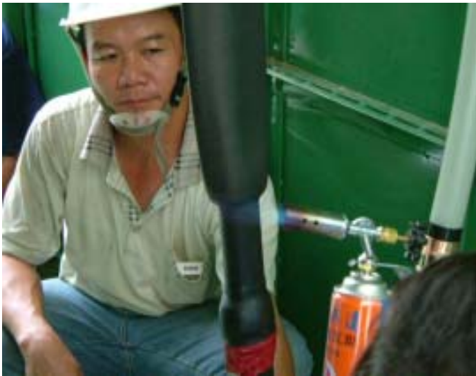
高壓電纜電纜頭處理
