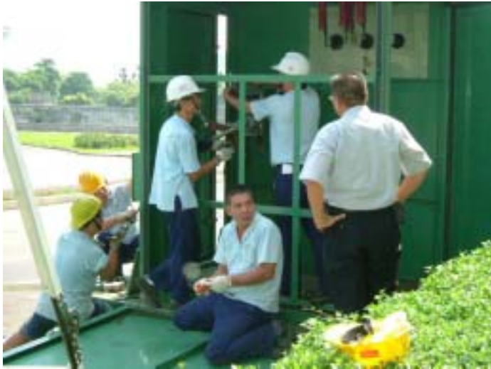
DS盤體修復施工照片一
